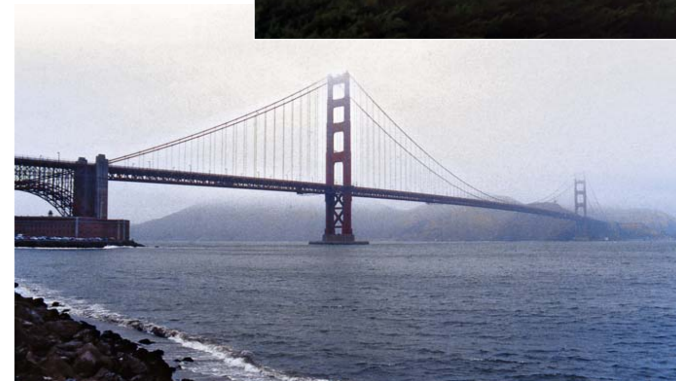
Golden Gate Bridge přemostuje Sanfranciskou zátoku v místech, kde se otevírá do Tichého oceánu. Dostavěn byl v roce 1937 a patří mezi technické divy moderního světa. Jeho délka je 2 737 metrů, výšku má 227 metrů. Denně přes něj přejezdí 118 000 automobilů.
