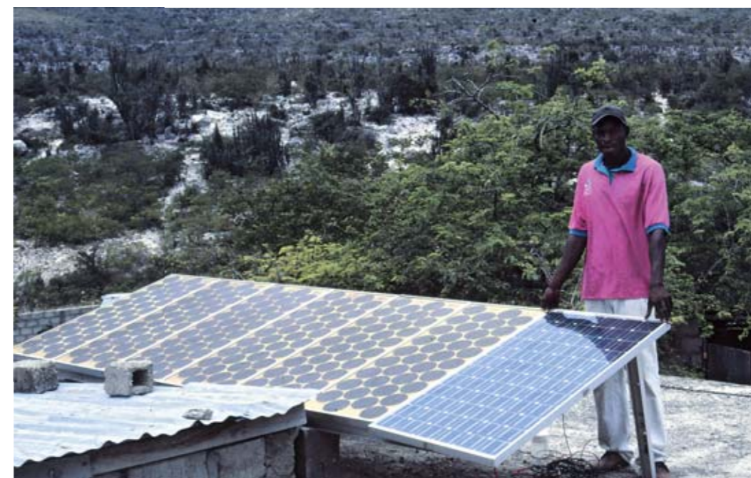
Další solární panely se podařilo získat a nainstalovat na faře. Díky tomu lze svítit, využívat počítač a mít funkční ledničku. Na faře lze používat i dieselový generátor na výrobu elektřiny, ale nafta je drahá a musí se dovážet z veliké dálky.
