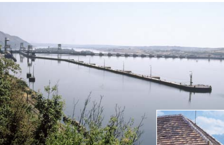
Na dohled jsme měli velké vodní dílo Železná vrata, které bylo vybudováno v letech 1946–1972. Přehrada je dlouhá 1200 metrů, vysoká 63 metrů. Po dokončení zvedla přehrada hladinu Dunaje o 33 metrů. Hydroelektrárna má výkon 2100 MW (ekvivalent dvou velkých jaderných reaktorů), o vyrobenou elektřinu se dělí oba státy.
