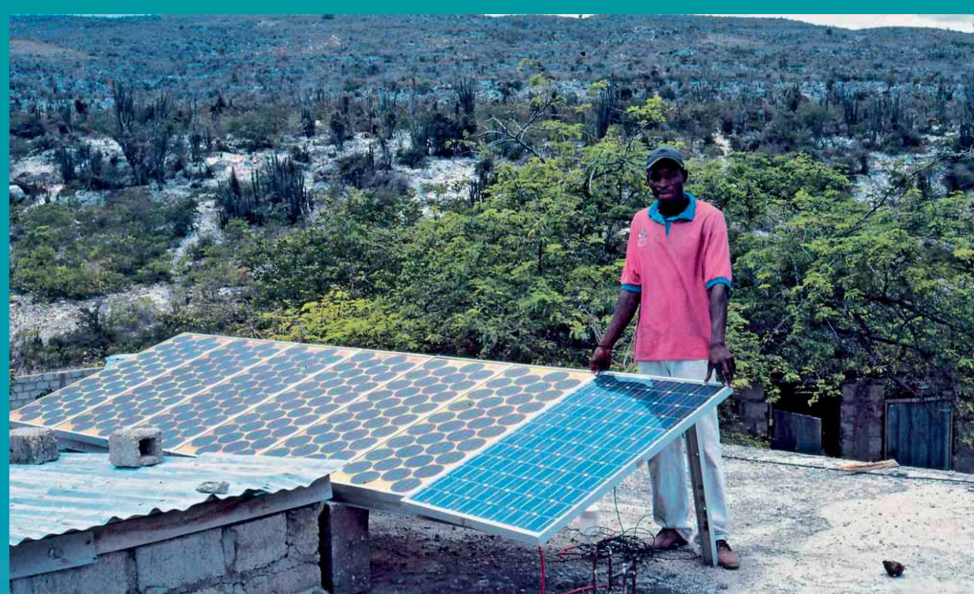
Solární panely na střeše misijní stanice v Baie de Henne. (Haïti)
